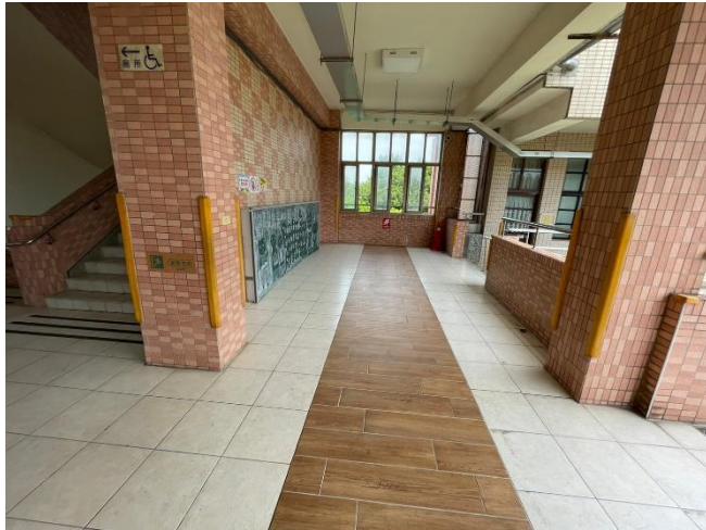
後棟東側三樓之轉角處
