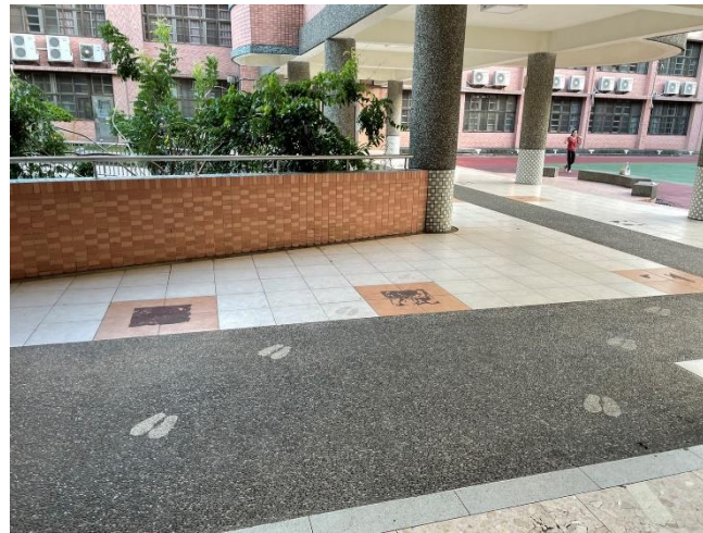
西側 1F 風雨走廊
