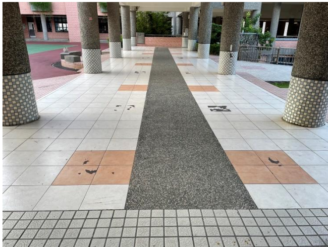
西側 1F 風雨走廊
