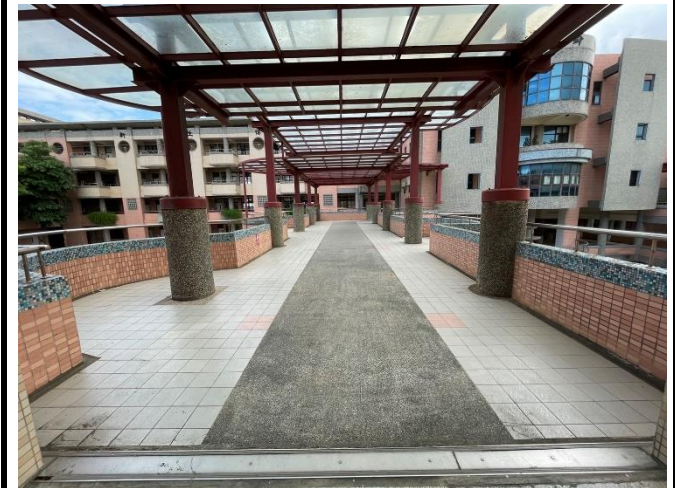
西側二樓風雨走廊
