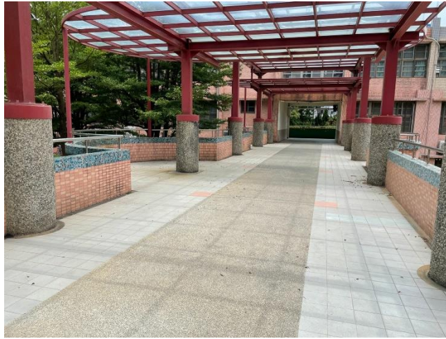
東側二樓風雨走廊
